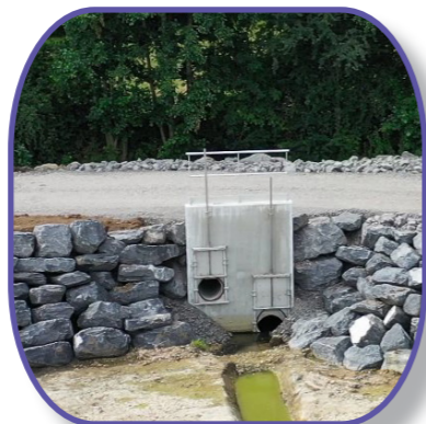
Ouvrage de sortie (régulation du bassin)
