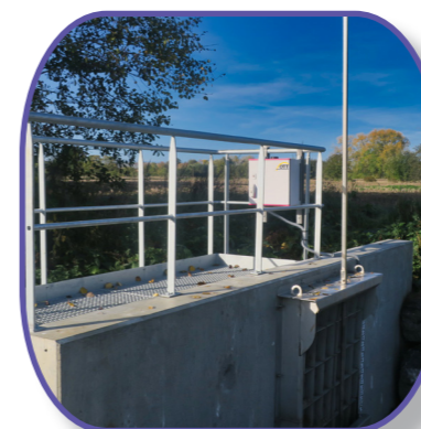
Ouvrage d'entrée (régulation du bassin)
