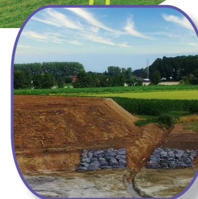
Fossé d'alimentation de la mare
