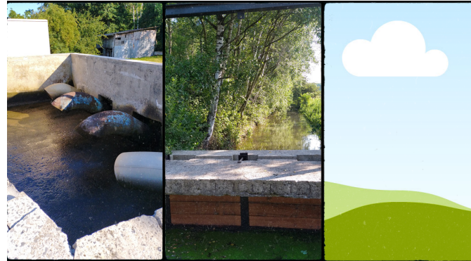
Tuyauteries de sortie des pompes de la station à changer
