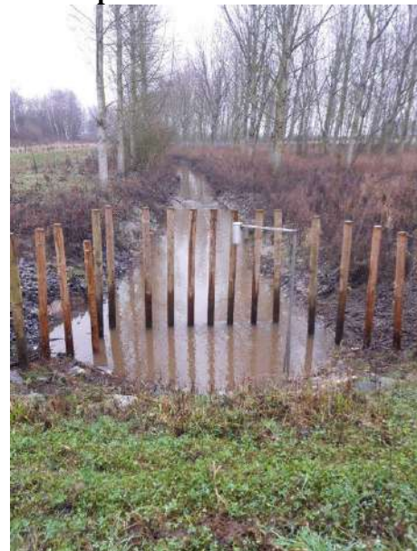
Photo après intervention
