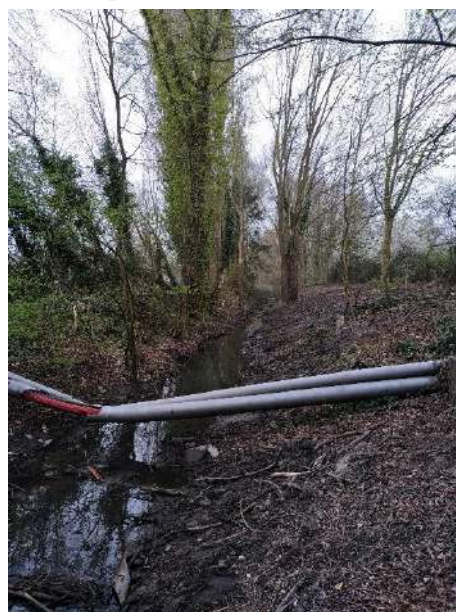
Photo après intervention
