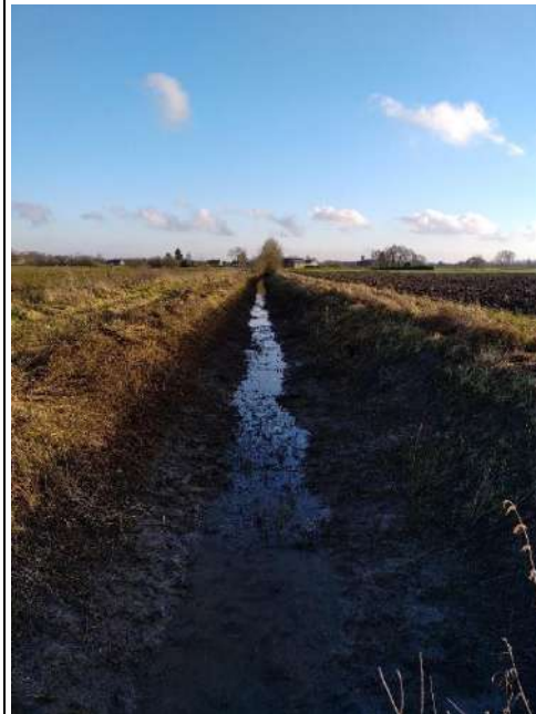
Photo après intervention
