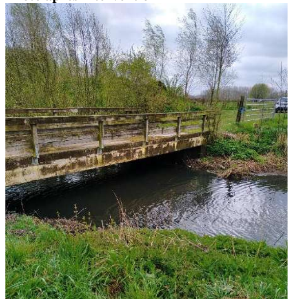
Photo après intervention
