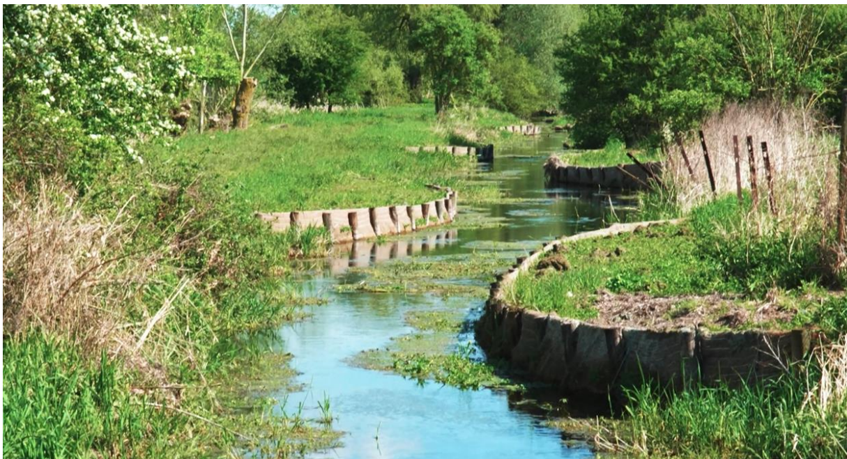
Figure 5 : reméandrage du courant de la Fontaine d'Hertain avec l'aménagement des banquettes végétalisées - extrait vidéo drone Hellix'lr
