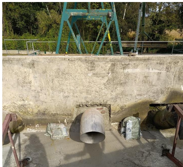
Figure 8 : nouvelle tuyauterie en inox sur la station St Charles
